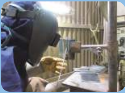
被覆アーク溶接
