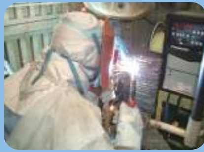
CO 2 ・MAG溶接
