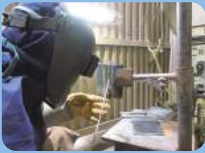
Soldadura electrodo revestido
