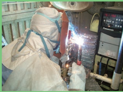
CO 2 ・MAG溶接
