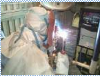
soldadura MIG・MAG
