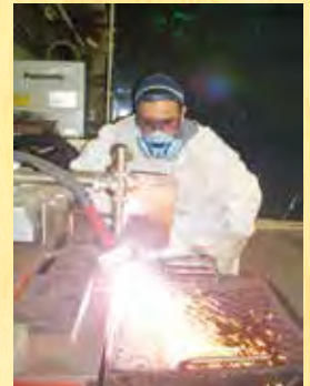
プラズマ切断
